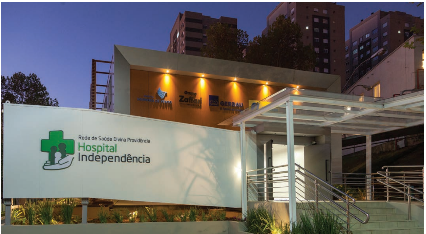
Valor para a sociedade: Gerdau ajudou a construir o centro de tratamento anexo ao Hospital Independência na capital gaúcha
